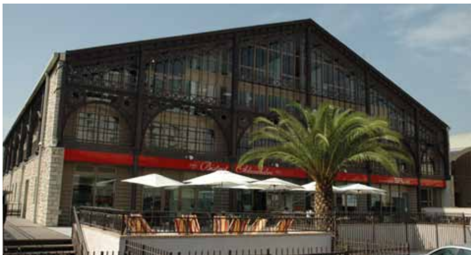
Un exemple de projet où la coopération entre acteurs a fonctionné : la station Alexandre est le symbole de la réussite des Zones franches urbaines à Marseille. (Photo : mairie de Marseille 13-14)
